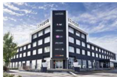
Imagen de la fachada de Complejo Castejón
