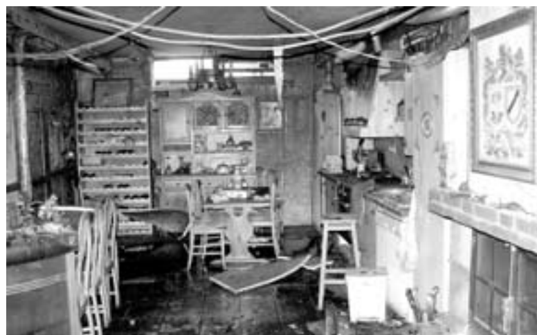
La bodega, después de la actuación de los bomberos. FOTO: M.A. GALILEA
